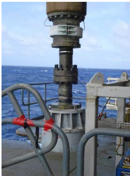
Figura 30: Colar de anodo instalado no conector
