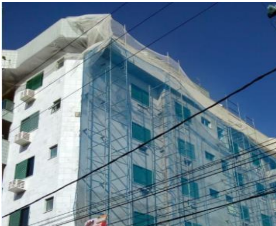
Figura 17: Reforma de fachada em andamento
