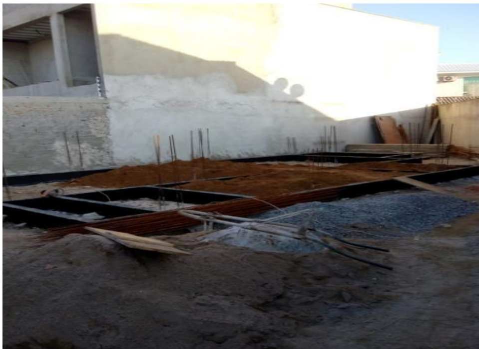
Figura 19: Compactação e Montagem das armaduras
