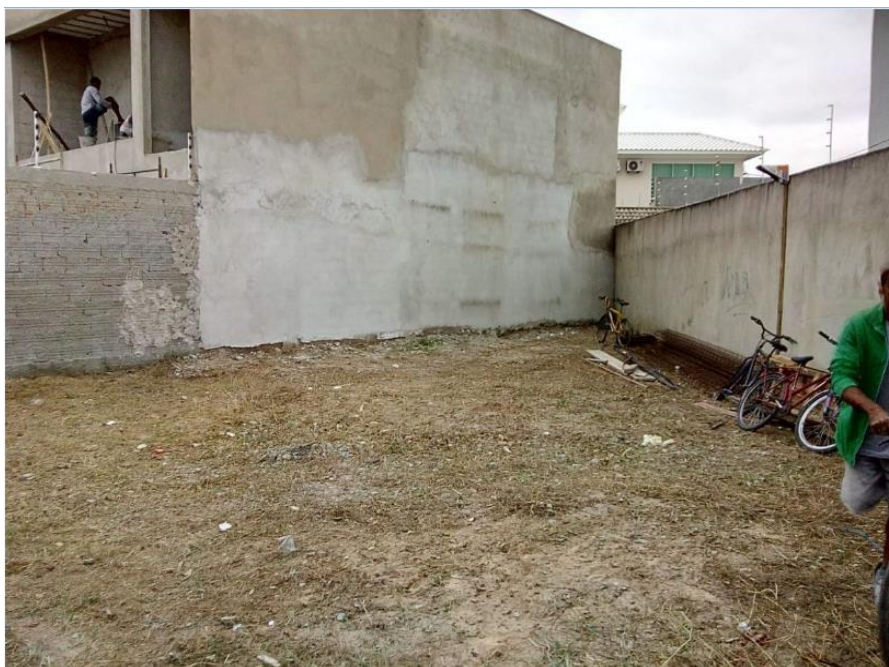
Figura 18: Limpeza e nivelamento do terreno
