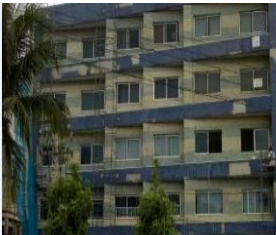
Figura 16: Fachada antes da reforma
