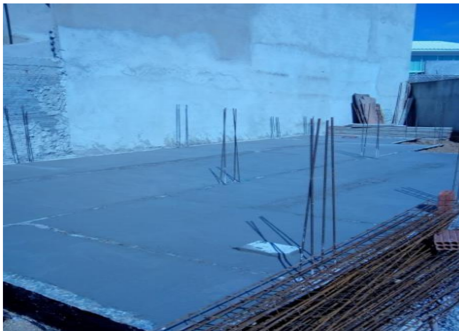
Figura 20: Concretagem da Fundação
