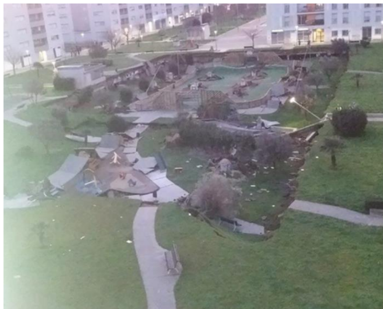
Figura 2 – Colapso de garagem subterrânea devido à punção em Santander, Espanha
