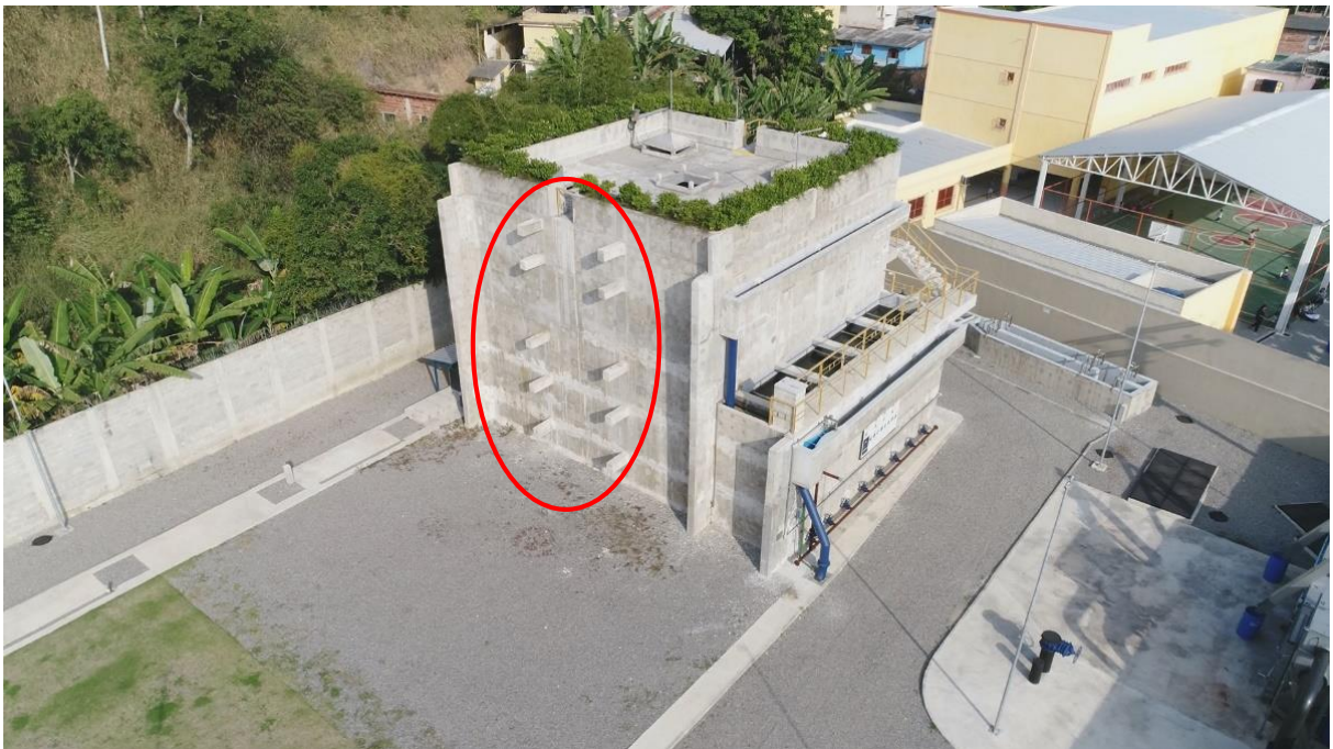
Figura 25: Vigas em espera para estrutura de um novo módulo do reator.
