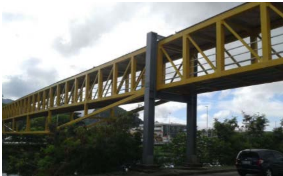
Figura 3-2: Passarela instrumentada (Fonte: BRUNET et al. , 2021)
