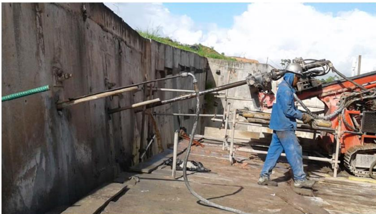
Figura 19 - Atividades de perfuração sendo executadas.
