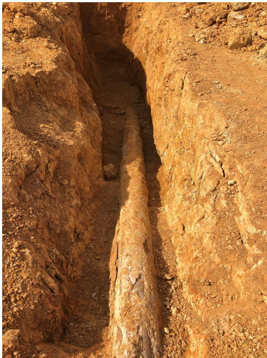
Figura 9 - Exumação de ancoragem reinjetável.
