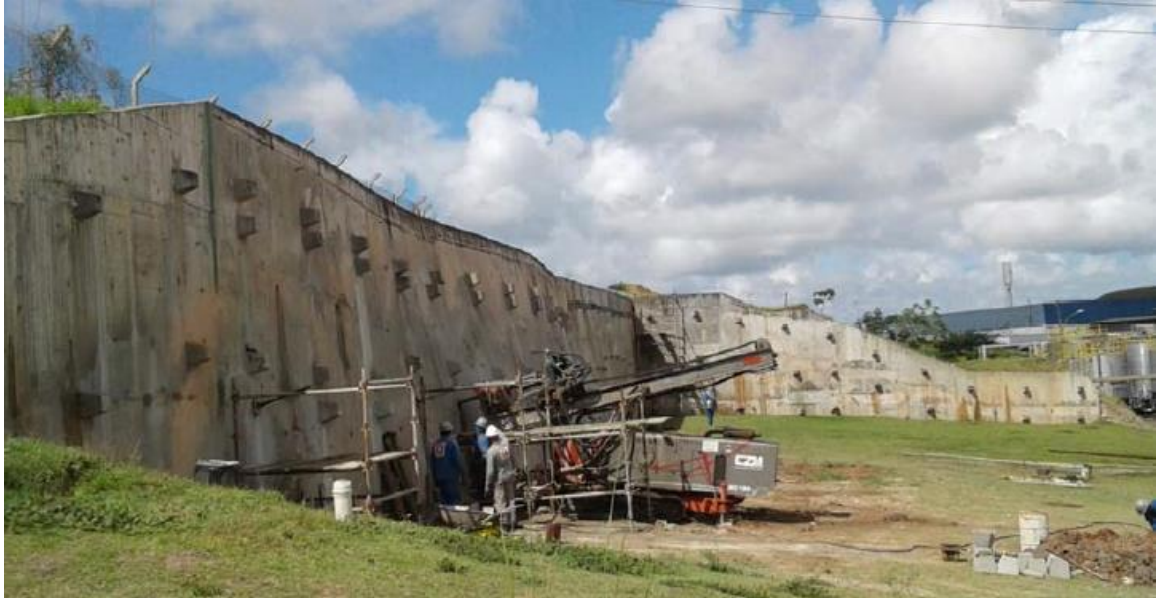
Figura 24 - Recuperação da cortina em fase final, com praticamente todos os tirantes deficientes substituídos.
