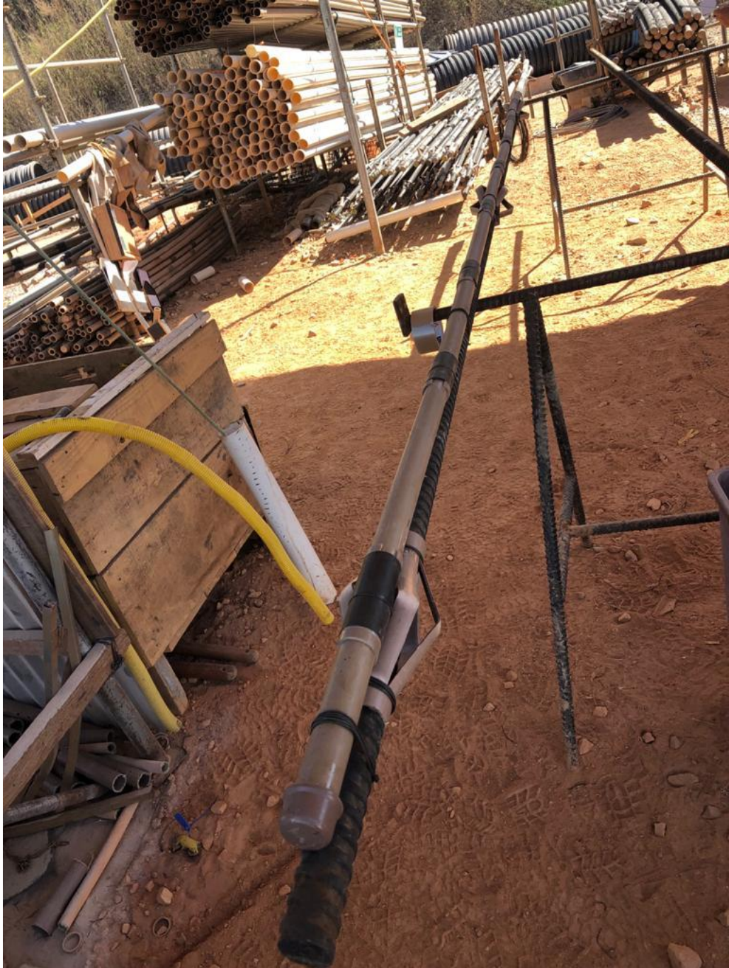
Figura 7 - Espaçador e tubo de injeção feito de PVC dotado de válvulas manchetes. Montagem de tirante constituído de monobarra.
