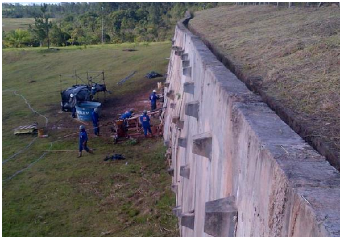
Figura 14 - Cortina atirantada durante a execução dos serviços.
