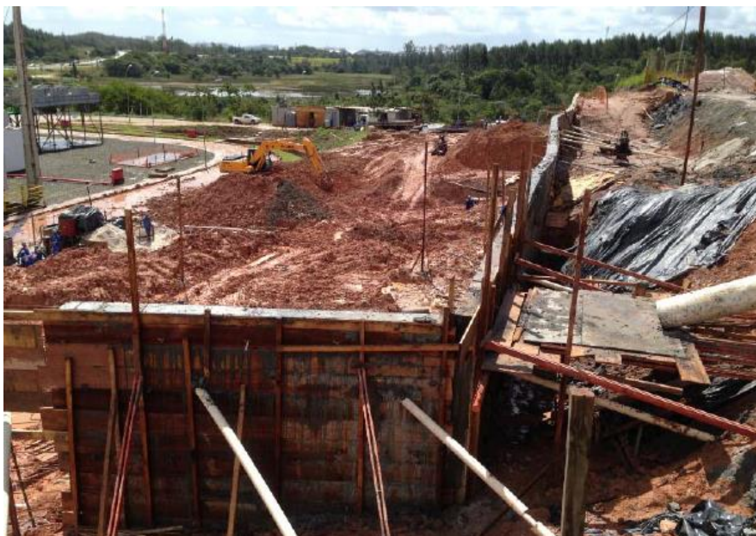
Figura 13 - Vista geral antes da contenção
