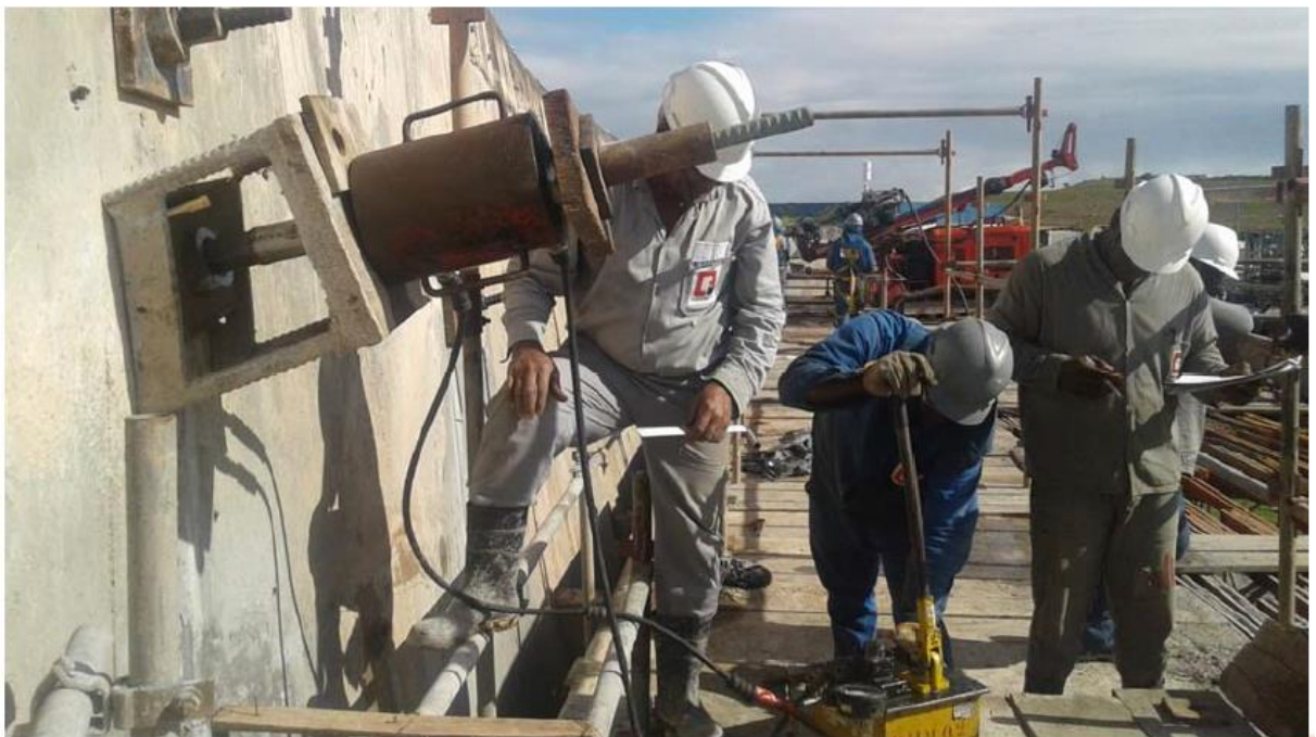
Figura 23 - Realização de ensaio com a utilização de macaco hidráulico + bomba.
