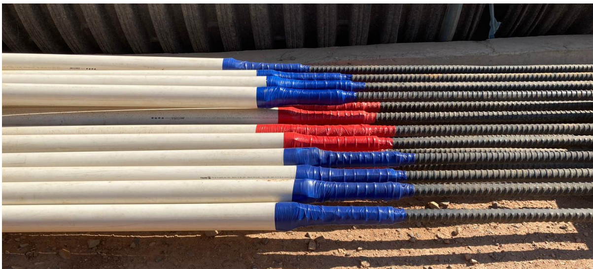
Figura 8 – Detalhe da transição entre trecho livre e trecho ancorado com utilização de fita especial para vedação do trecho livre protegido por tubo plástico branco.
