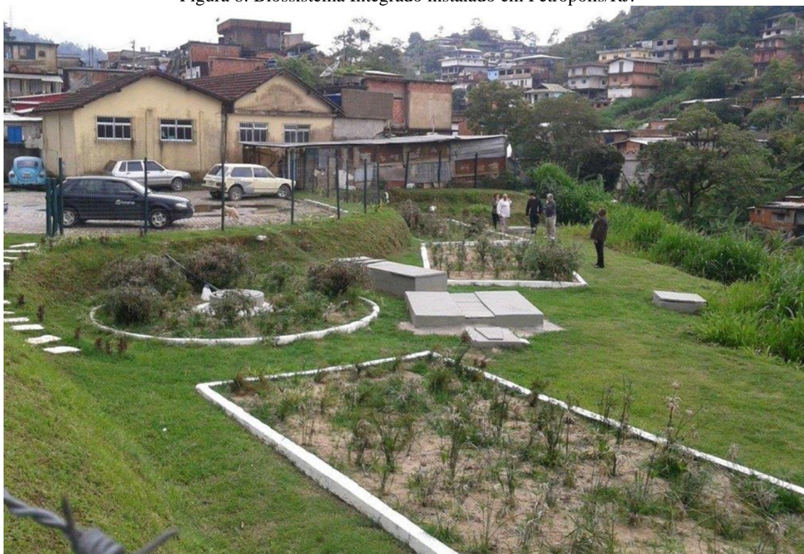
Figura 8: Biossistema Integrado instalado em Petrópolis/RJ.
