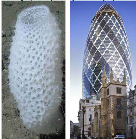
Figura 19 – Gherkin Tower : (a) esponja da espécie Euplectalla aspergillum e (b) estrutura da edificação.
