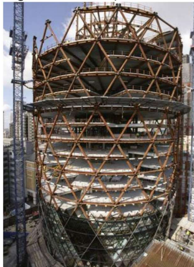
Figura 20 – Construção do edifício.
